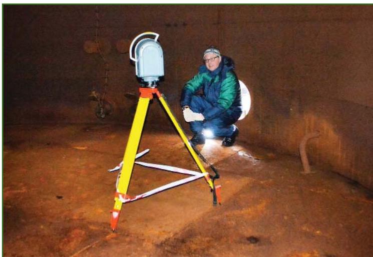
Рис. 2 Сканирование внутри резервуара Trimble TX8
